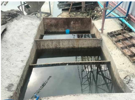
ภาพที่ 33 บ่อตกตะกอนน้ำเสียจากการล้างล้อรถ
