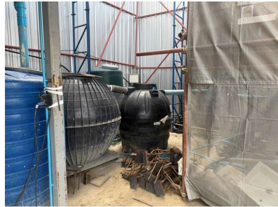
ภาพที่ 32 ถังบำบัดน้ำเสียสำหรับห้องน้ำ
