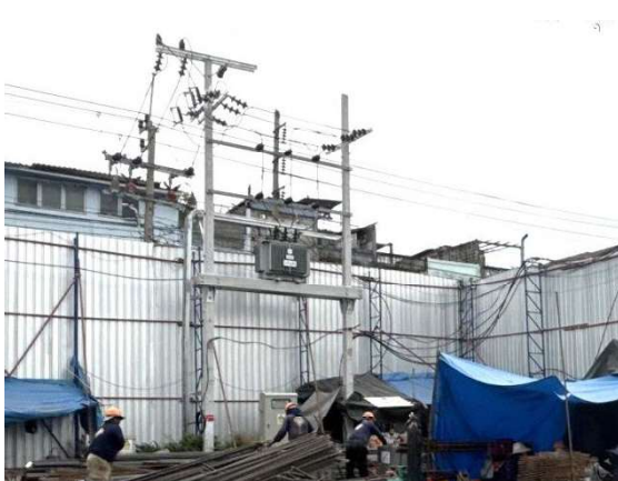
ภาพที่ 42 หม้อแปลงไฟฟ้าของโครงการ
