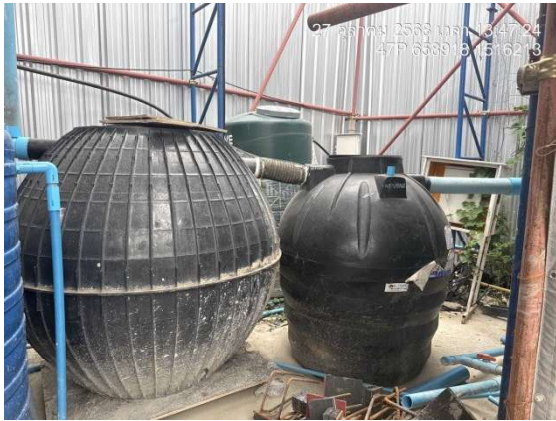
ภาพที่ 32 ถังบำบัดน้ำเสียสำหรับห้องน้ำ
